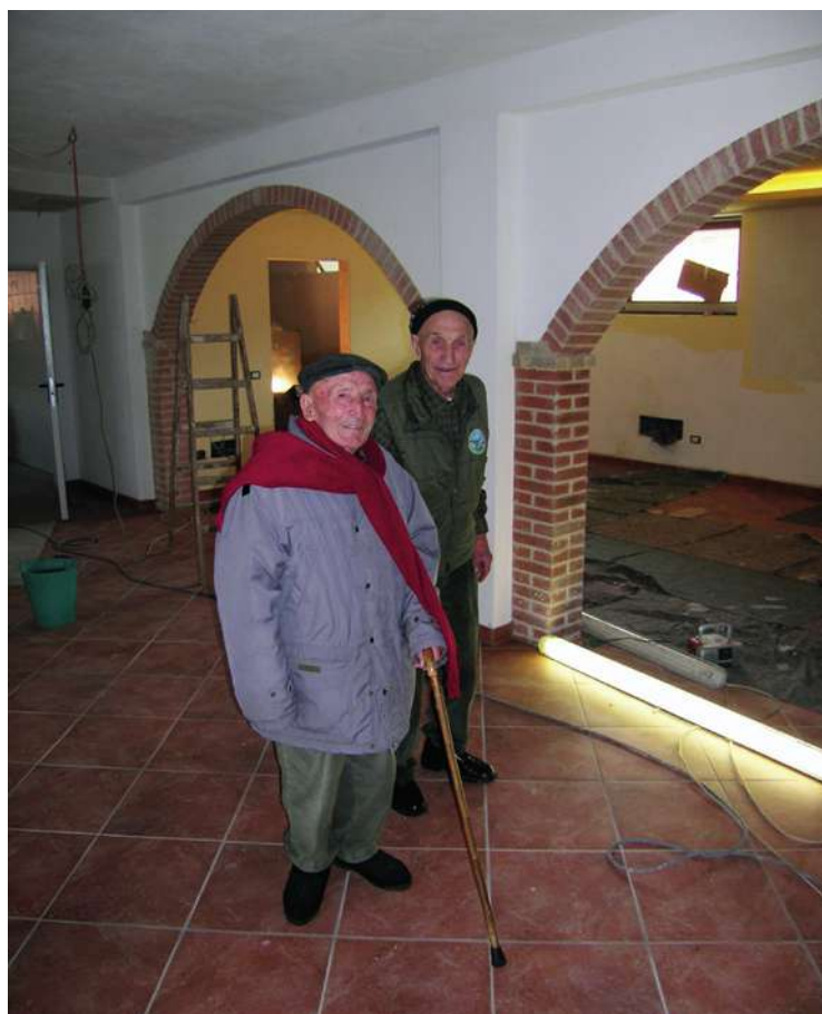
Bepi & Bepi in posa all'interno dei locali della nuova sede alpini.
