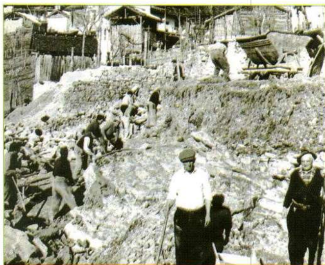
Il lavoro di scavo nella Casa della Gioventù. Sono di turno le famiglie sotto la chiesa, in primo piano c'è Piero Monzoi dei Moggi
